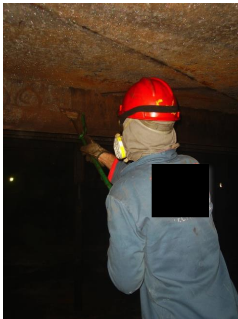
Figura 1 - Raspagem do teto do tanque
