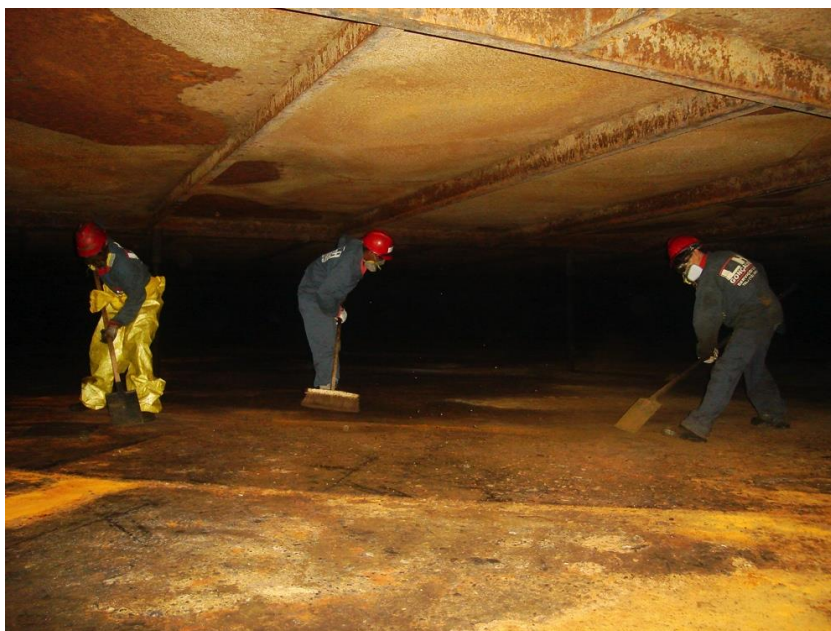
Figura 2 - Raspagem do piso do tanque
